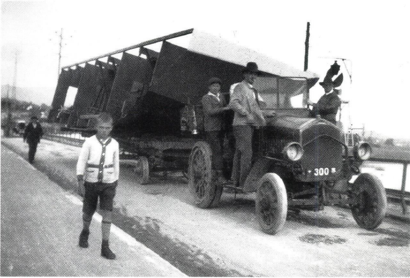
Ein Viertel des Schiffsrumpfes der zukünftigen Autofähre auf dem Transport von Ürikon nach Luzern.
